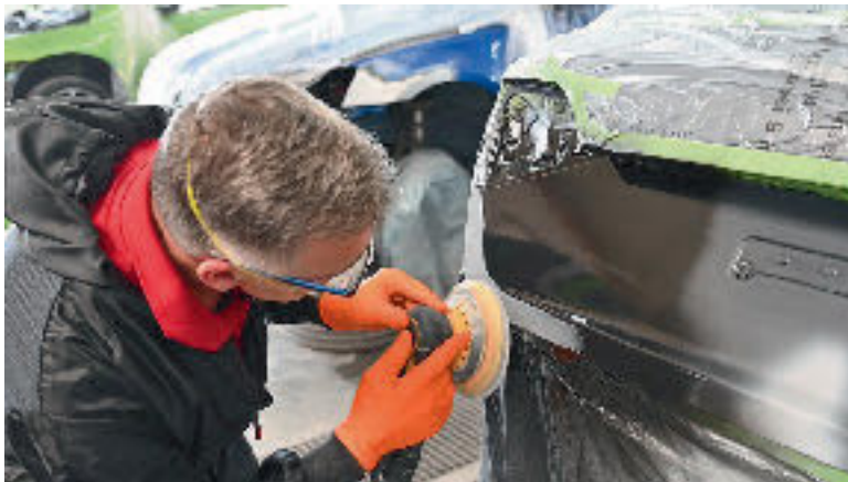
Praktische Besonderheit. Der Füller trocknet glänzend aus. Wo geschliffen wurde und wo nicht, ist auch ohne Kontrollschwarz perfekt zu sehen.
